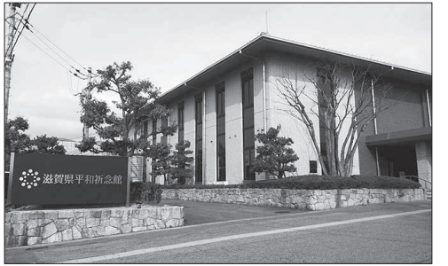
滋賀県平和祈念館の屋根を借りて市民発電所3号機を設置
