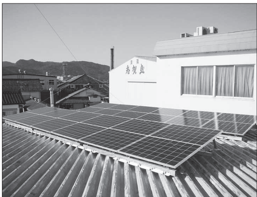
スマートメーターを設置した市民共同発電所2号機
