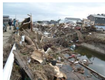
舟入川排水路(亶理町)被災状況
