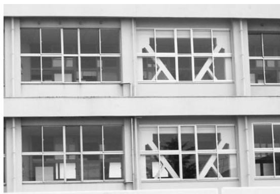
耐震工事を施した校舎の例 (内付け鉄骨ブレス補強)
