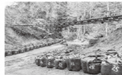
枝沢橋りょう応急処置後 幅28m高さ4.5mの盛り土が流出
