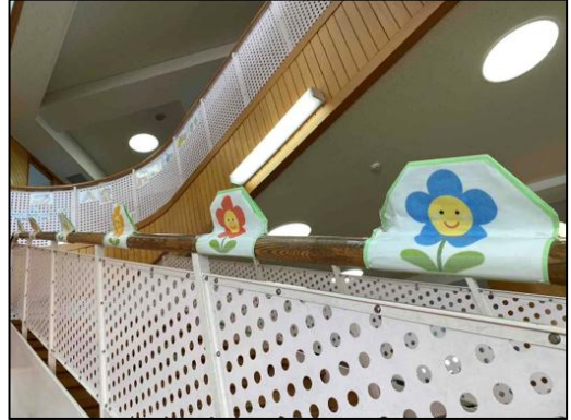
階段手すりに取り付けたパネル
