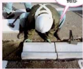
L型側溝の補修
