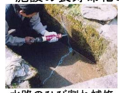
水路のひび割れ補修
