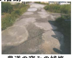
農道の窪みの補修
