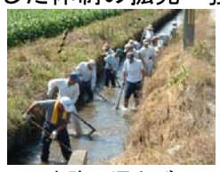
水路の泥上げ
